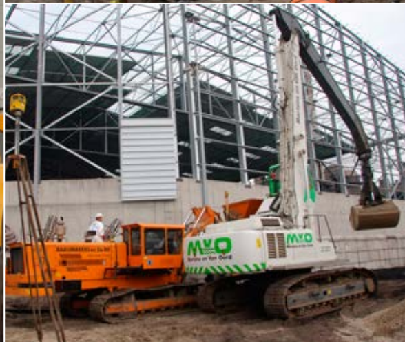
Aanbrengen van de pompputten
