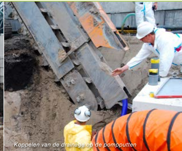
Aanbrengen van de pompputten
