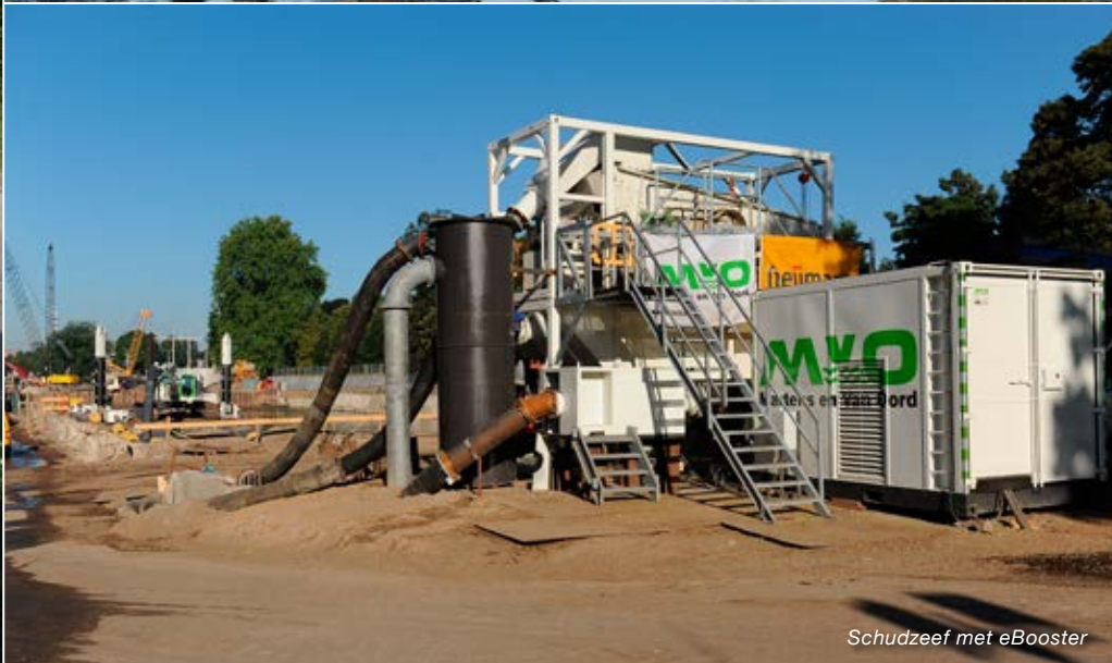
Baggerponton in de bouwkuip
